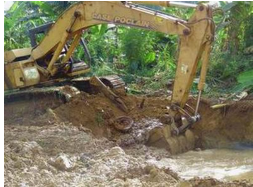
Lavori di bonifica dell'Ano-Assué
