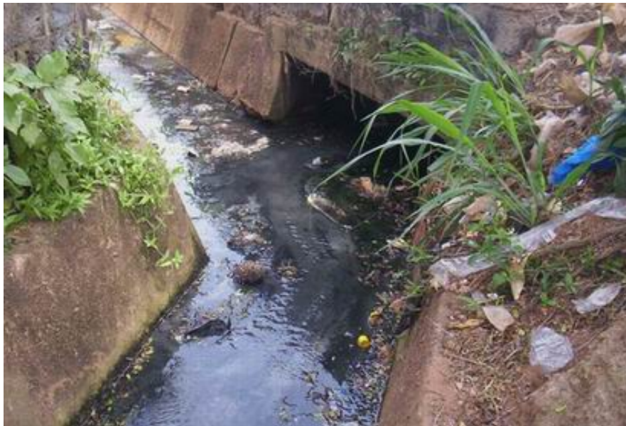
Canalizzazioni a cielo aperto per le acque piovane.....
