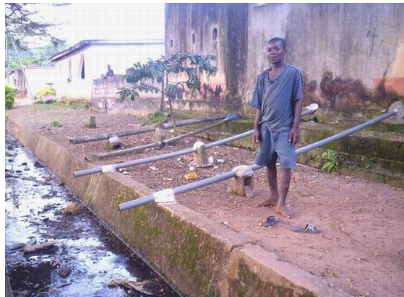
..... qui sont normalement utilisées comme évacuation d'égouts
